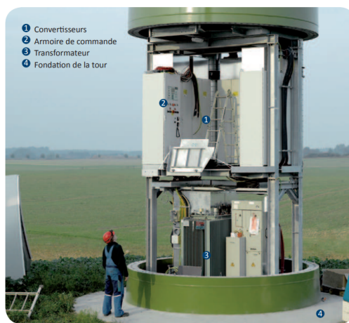
FIGURE 1.6 – Schéma de l'intérieur d'un mât 2
